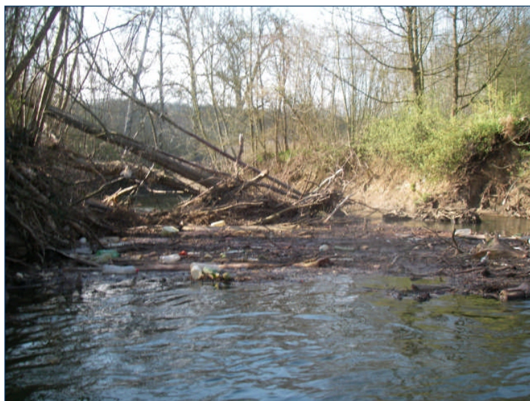
Figure 64 : Exemple de l'érosion subie par la berge suite à l'implantation d'un embâcle majeur dangereux pour la tenue du lit de la rivière (Source : Association de canoë de Jouarre, journée de nettoyage sur le Petit Morin 2006)
