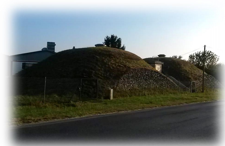
© SAGE des Deux Morin – Captage d'alimentation en eau potable – Esternay
