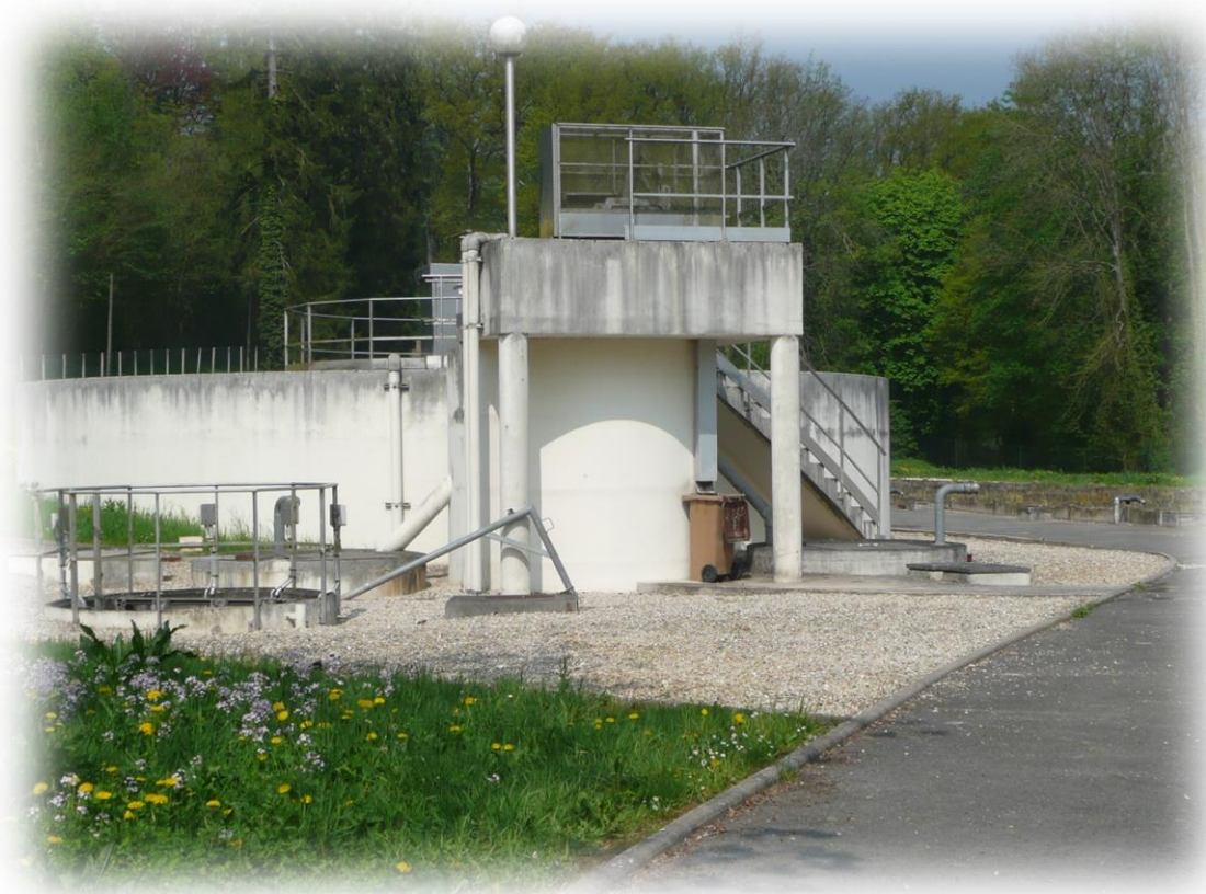
© SAGE des Deux Morin – Station d'épuration – Jouy-sur-Morin
