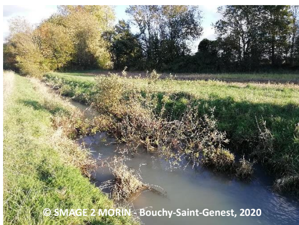
Figure 35 : Entretien de ripisylve inadapté engendrant des problématiques d'écoulement
