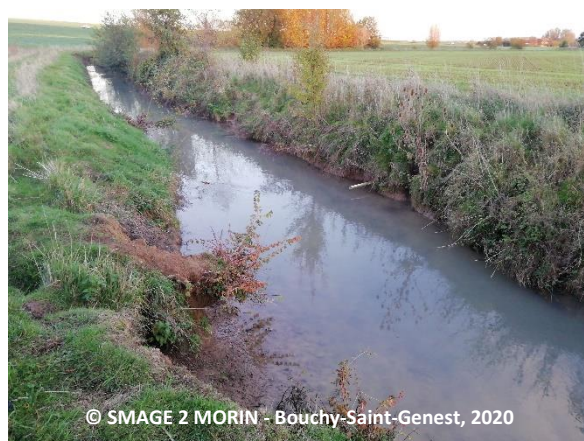
Figure 36 : Erosion de berge et surlargeur du lit mineur visible
