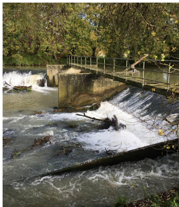
Figure 9 : Photographie du clapet et du déversoir de Mouroux
