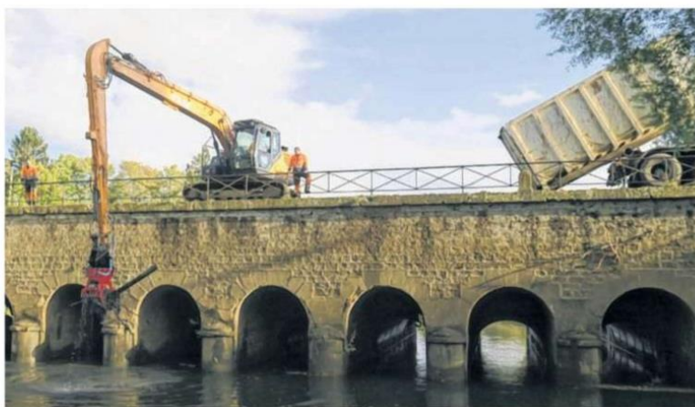
L'enlèvement des embâcles a commencé au pont-canal de Condé-Sainte-Libiaire.
