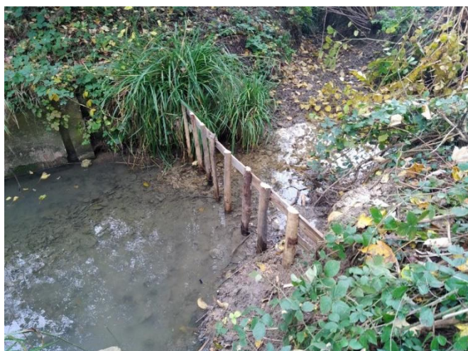
Figure 34 : Photographie du piège à embâcle en amont de la grille du Ru de Lochy © SMAGE 2 Morin
